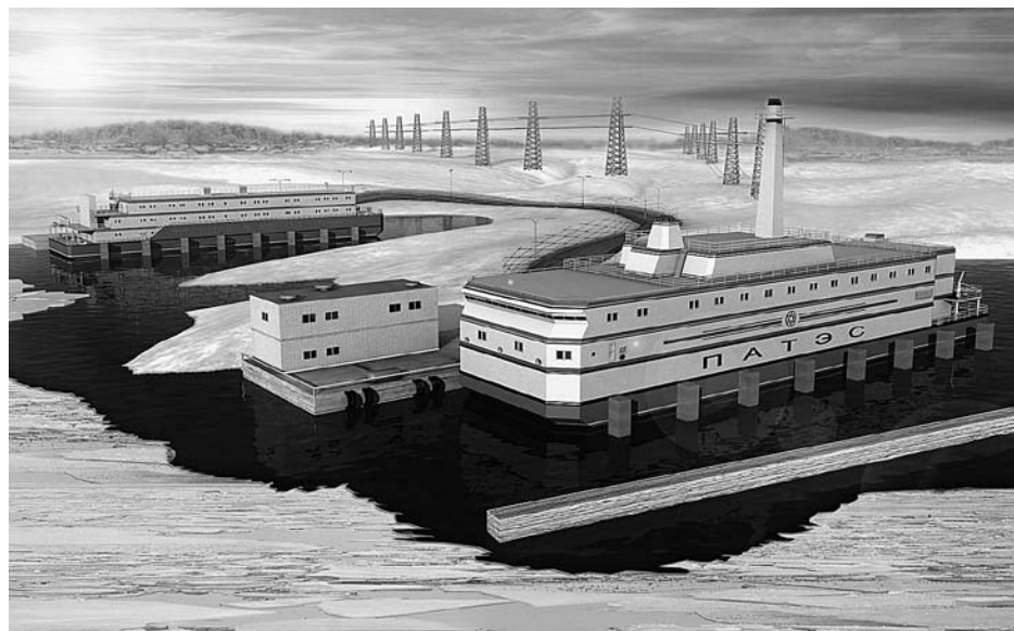
Плавучая атомная теплоэлектростанция
