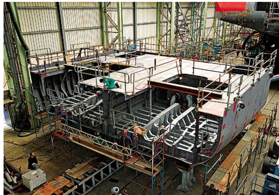
Судно для транспортировки контейнеров с отработанным ядерным топливом (ОЯТ) и радиоактивными отходами (РАО). Блок машинного отделения. Пр. 00720
